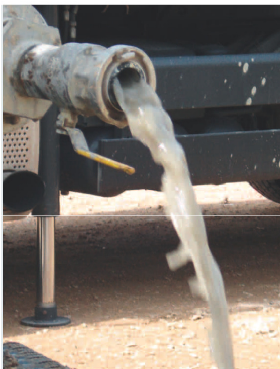
wypływ płuczki wiertniczej wypieranej z otworu
